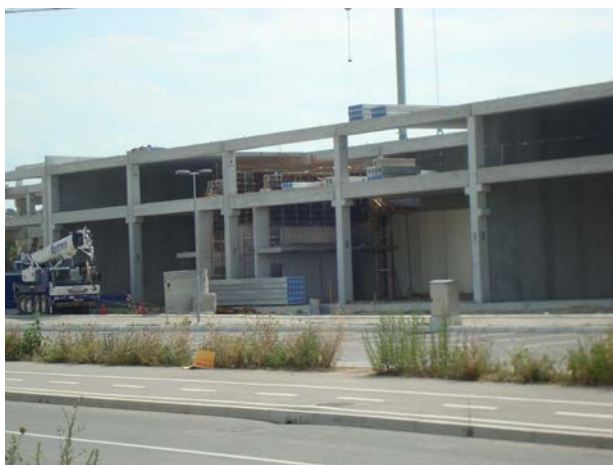
Slika 3 Gradnja poslovnega objekta
